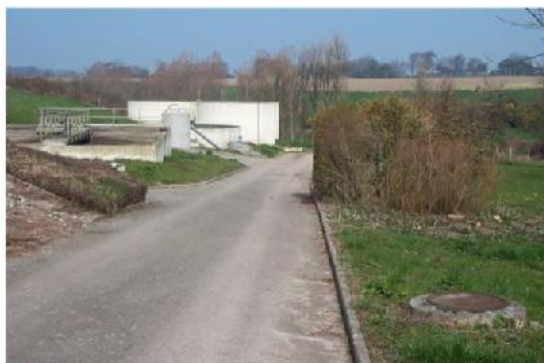
Figure 33 : Vue de la voirie interne de la station d'épuration actuelle des Loges
