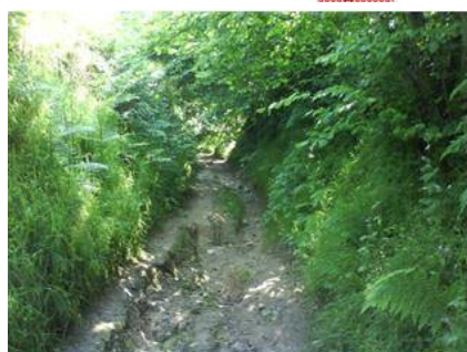
Chemin situé entre "Les Hogues" et le point bas (47.51 m Géoportail ) = ravine très marquée
