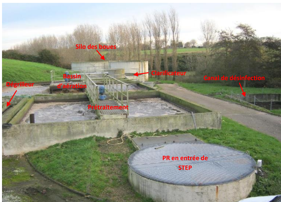
Figure 17 : Vue générale de la station d'épuration des Loges
