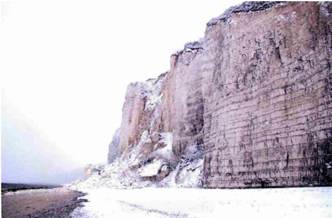
Figure 78 : Photographie des restes de l'éboulement de 2006
