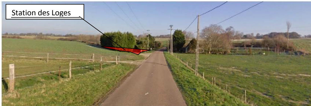
Photographie 14 : Contexte d'implantation de la station d'épuration des Loges
