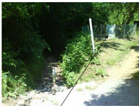
Poste existant du hameau "La Cave". La conduite de refoulement viendra de ce bois de "La Cave".
