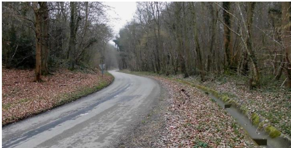
Photographie 12 : Vue de la RD279 depuis le site de la station d'Yport (vue vers l'amont)
